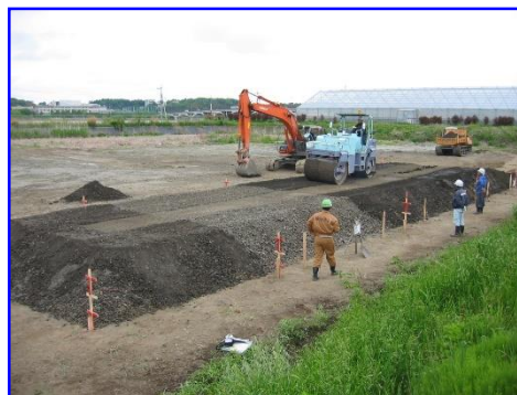
現場実証実験での試験盛土作製状況
