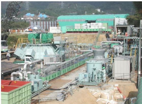
100 t バッチ処理設備
