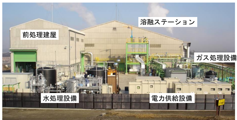
三重中央開発㈱ 三重リサイクルセンター内の処理設備
