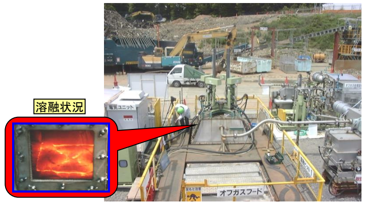
1 t バッチ処理設備（和歌山県橋本市において使用）
