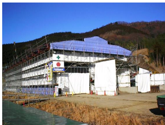
プラント建家
