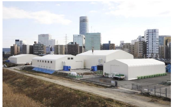
写真-2 施設の全景
