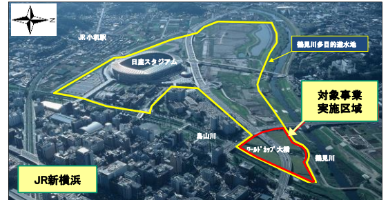
写真-1 鶴見川多目的遊水地及び対象事業実施区域
