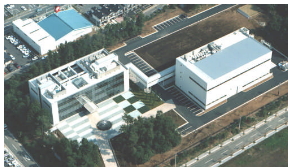
写真 1 研究棟(左)と実験棟
