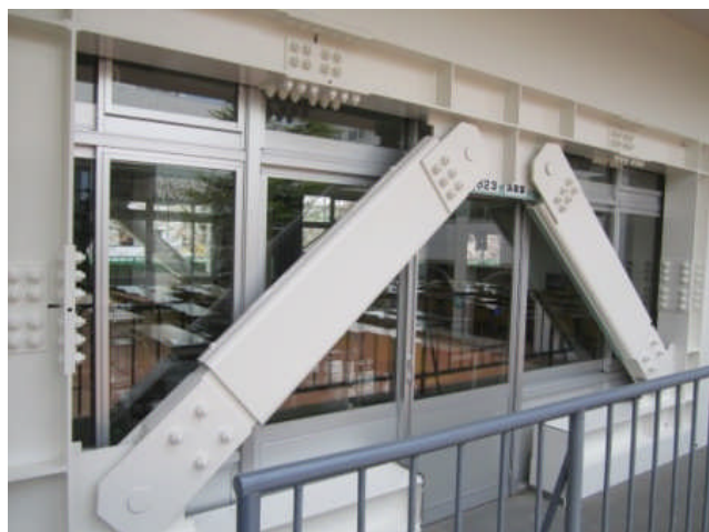
写真3 地震後のダンパー状況（被害なし）
