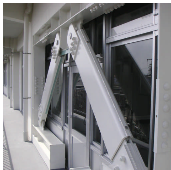
写真 2 粘弾性ダンパー設置状況
