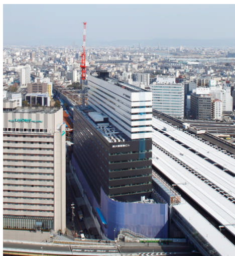
写真 1 施工状況写真（平成 24 年 2 月現在）
