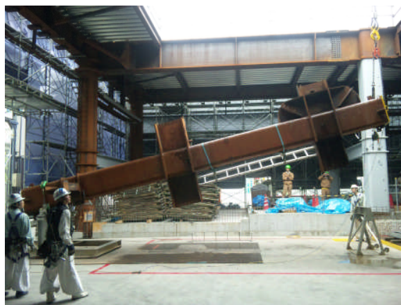
写真 9 仮設開口での柱建方状況
