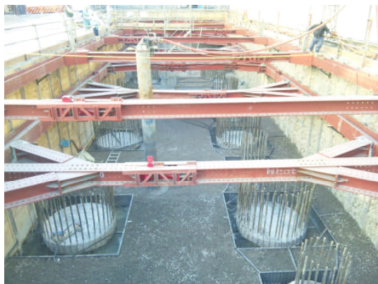
写真 5 2 段切梁設置状況
