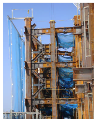
写真 7 先行ネット設置状況
