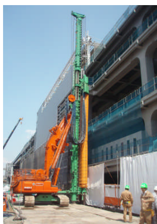
写真 4 山留工事状況
