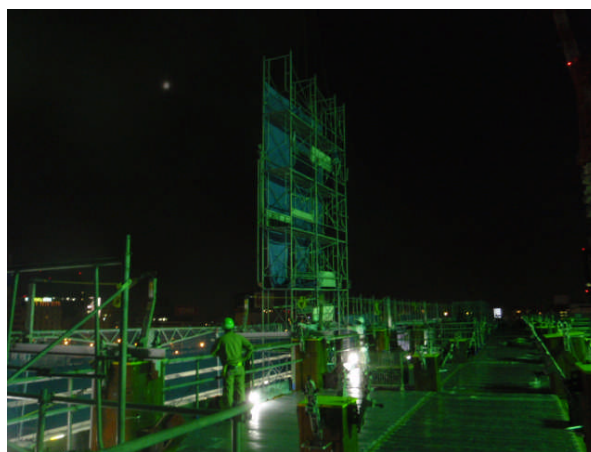
写真 10 外部足場ブロック化施工状況（夜間作業）
