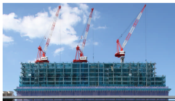
写真 6 鉄骨建方状況 (南面)
