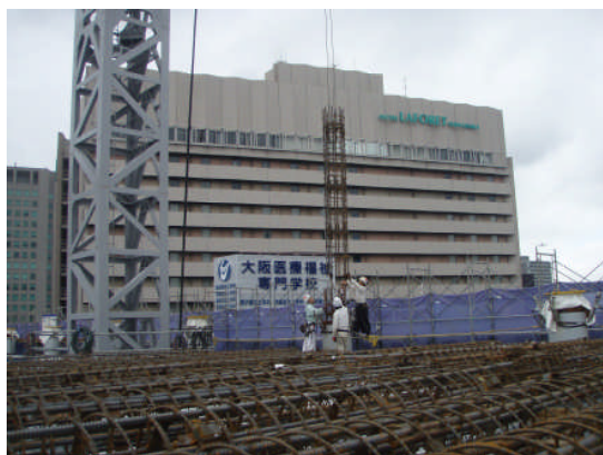
写真2 内蔵鉄筋ユニット吊り込み状況
