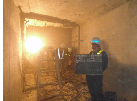
写真4 ハツリ仕上げ状況
