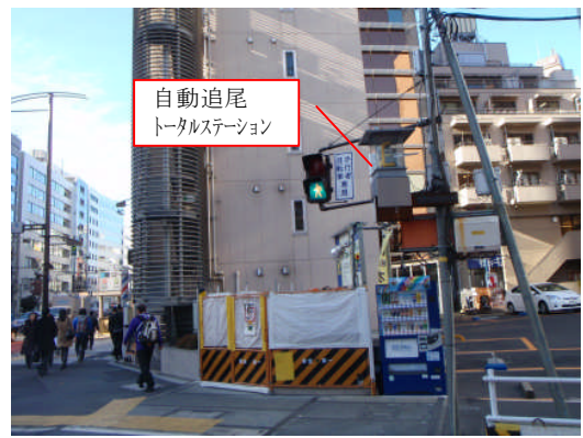
写真6 地表面沈下測定状況
