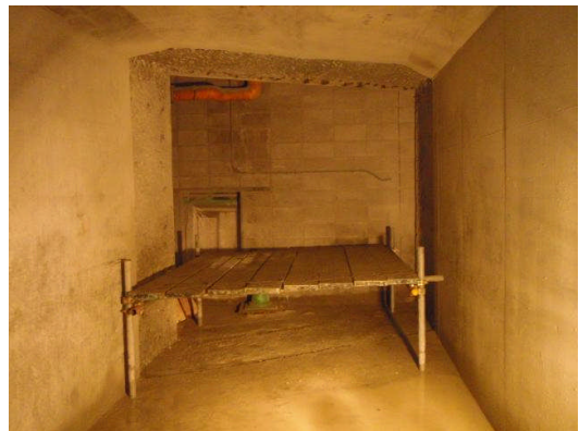
写真5 接続部施工完了状況
