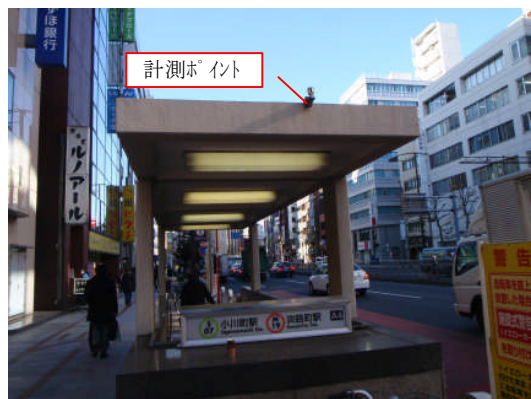
写真7 既設構造物測点設置状況
