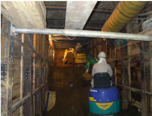
写真2 通路掘削状況
