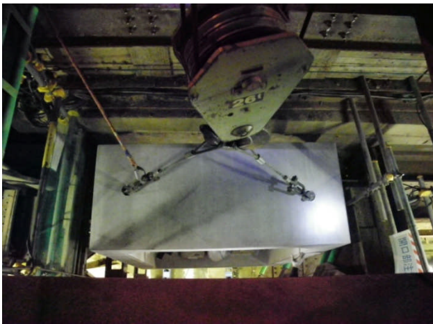
写真6 立坑内投入状況
