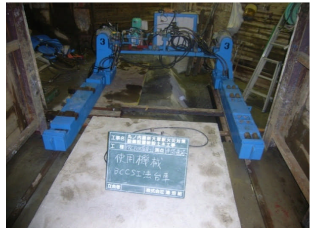
写真3 台座コンクリート
