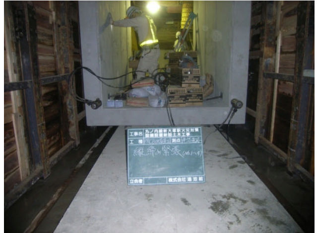
写真8 PC鋼棒縦締め状況
