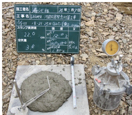
写真6 圧送後のコンクリート
