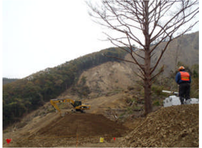
写真5 リモコンによる重機操作の様子
