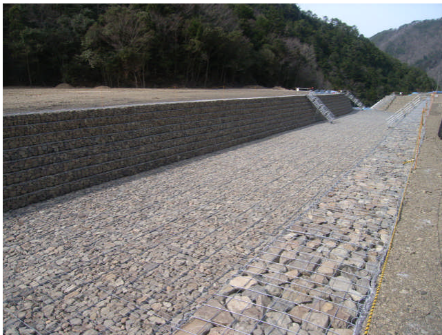
写真1 堤頂部仮排水路完成写真
