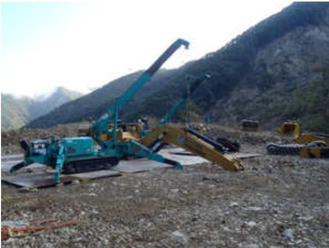
写真4 重機組立の様子
