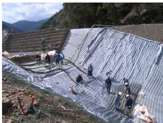
写真7 コンクリートの打設状況
