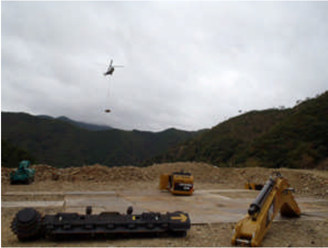
写真3 重機空輸の様子
