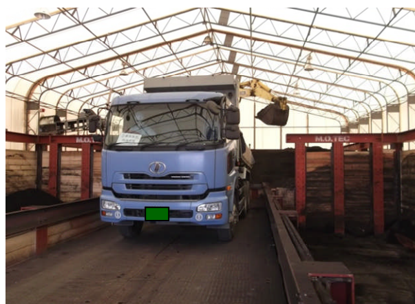
写真8 浄化土建屋内的の浄化物積み込み状況
