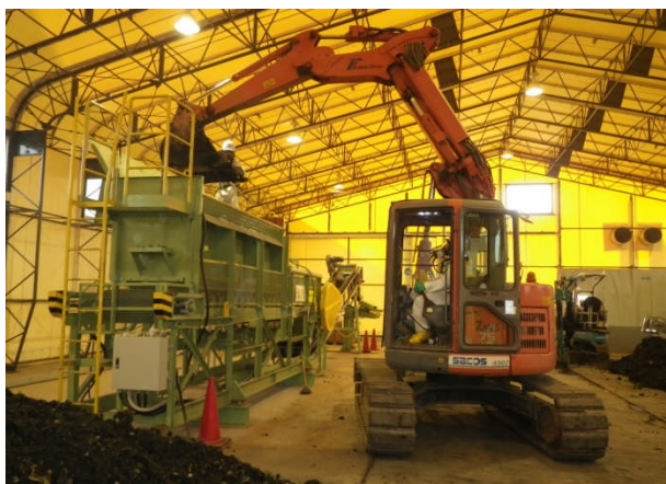
写真6 定量供給装置への投入状況
