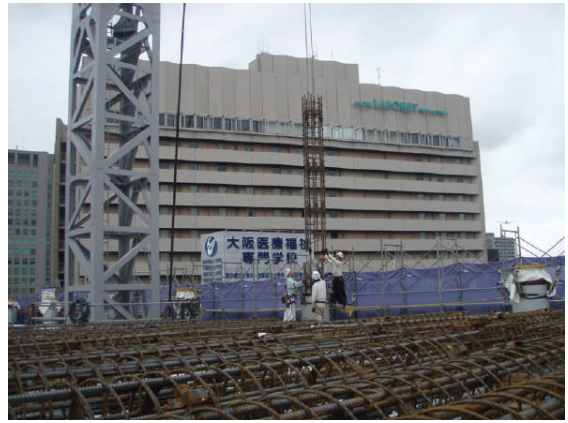
写真3 内蔵鉄筋吊込み状況 (STEP1)
