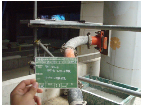
写真5 圧入施工状況 (STEP5)
