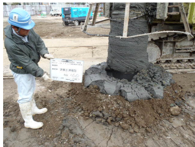
写真5 施工状況（置換土層確認）
