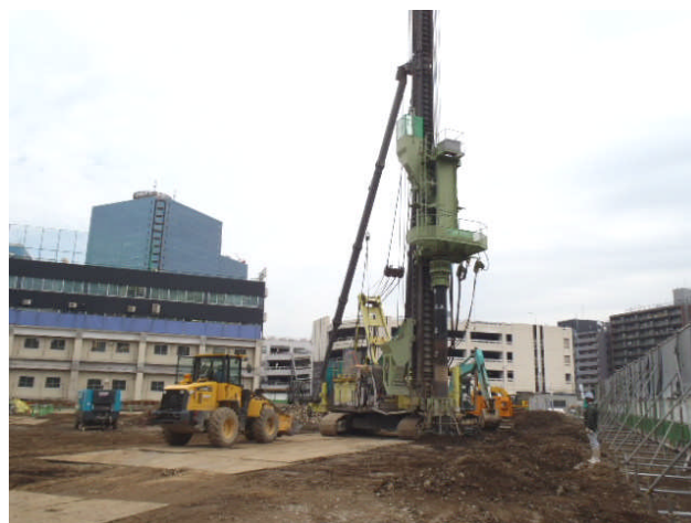
写真4 施工状況（外観）
