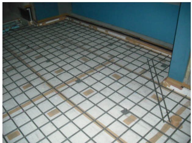
写真10 浮床の施工状況
