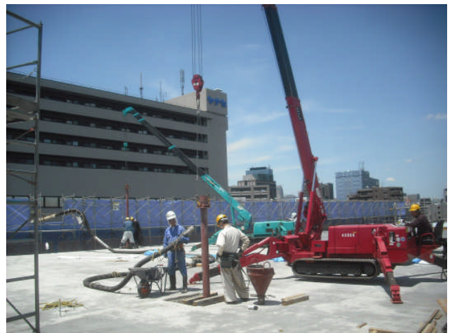
写真9 落とし込み充填施工状況
