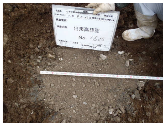
写真6 施工状況（改良杭径確認）
