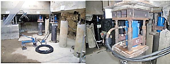
写真5 ジャッキ設置状況
