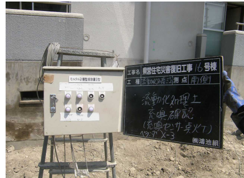
写真9 流動化土の充填性確認
