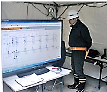
写真7 ジャッキアップ監視状況
