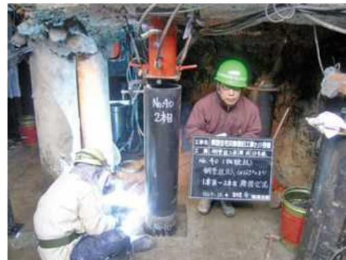
写真 4 鋼管圧入状況
