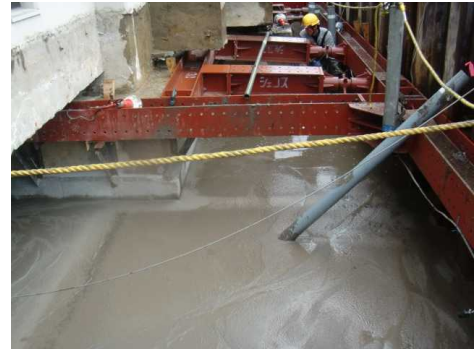
写真8 流動化処理土充填状況
