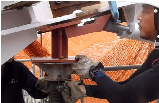
写真9 支保工反力解放状況
