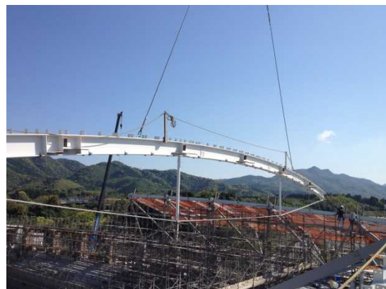
写真 7 張弦梁建方状況
