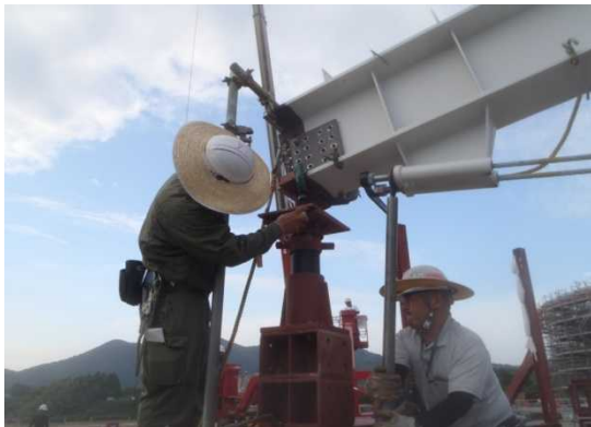
写真 4 ケーブル端部金具締め込み状況
