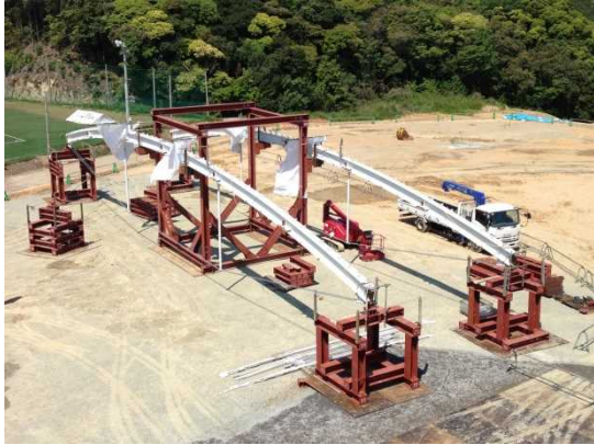
写真 3 張弦梁地組状況
