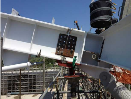
写真8 張弦梁建方状況
