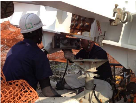
写真10 追加張力導入状況
