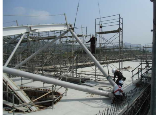
写真 5 斜柱部建方状況
