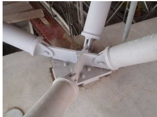
写真 6 斜柱脚部納まり
