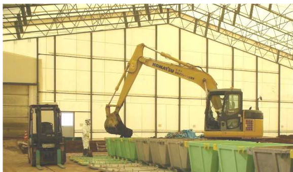
写真2 掘削建屋内での掘削状況
