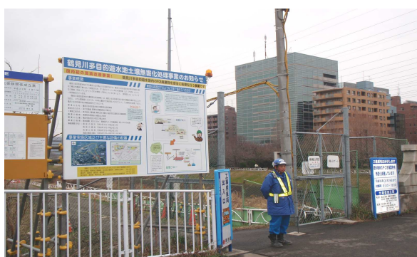
写真 13 工事説明看板（鳥山ゲート）
