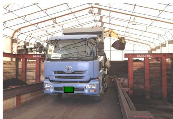
写真 7 浄化土建屋内での浄化物積み込み状況
