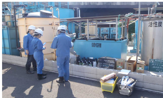
写真9 処理水サンプリング（横浜市立会）
