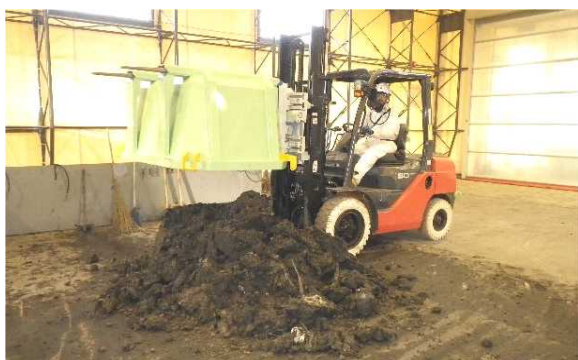
写真3 一時保管土 A 展開状況
