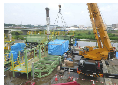
写真10 処理施設解体
