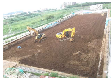
写真11 掘削ヤード埋戻し
