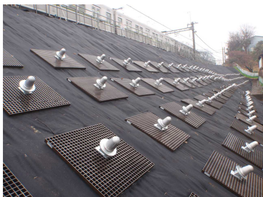
写真1 法面工（グリーンパネルと防草シート）
