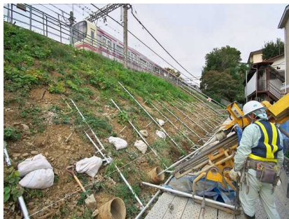
写真 2 表層の玉砂利部の処理
