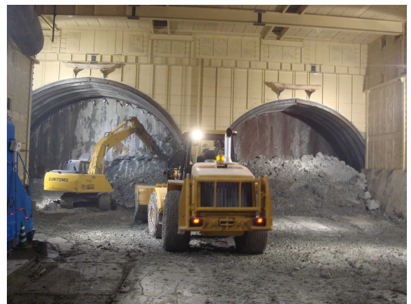
写真8 トンネル掘削状況（防音ハウス内）
