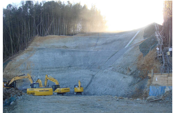
写真7 坑口切土法面状況
