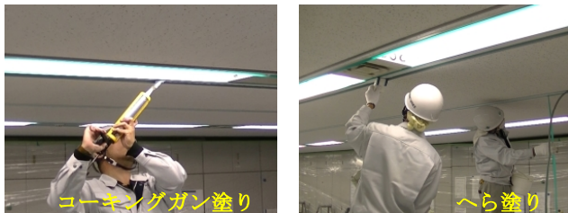
写真13 C S F P工法の施工状況 (繊維入り強化塗料の塗布)
