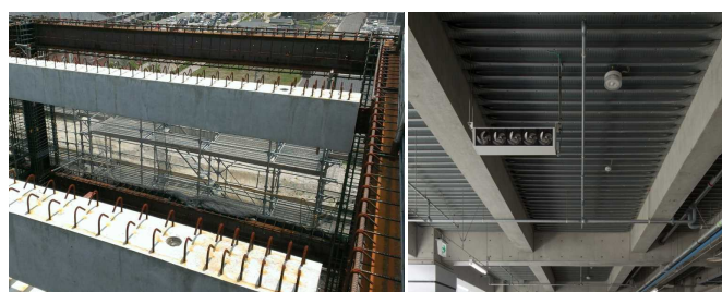
(a) 架設時の取付け状況 (b) 地下1階見上 写真6 PCa小梁施工状況
