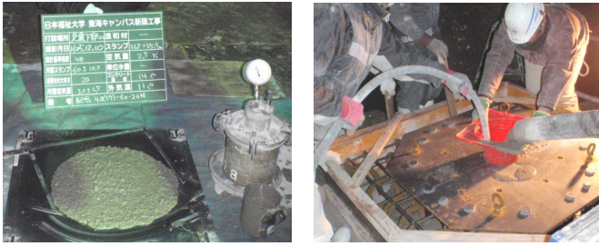
(a) コンクリート受け入れ検査 (b) コンクリート打設状況 写真3 コンクリート充填性確認試験
