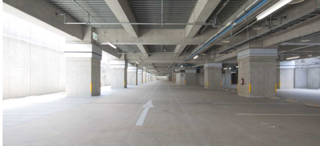
(a) 地下1階駐車場
