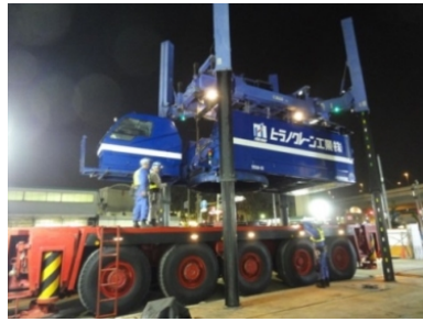
写真 5 リフターを用いたクレーン組立状況
