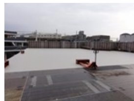
(長尺シート貼り)
