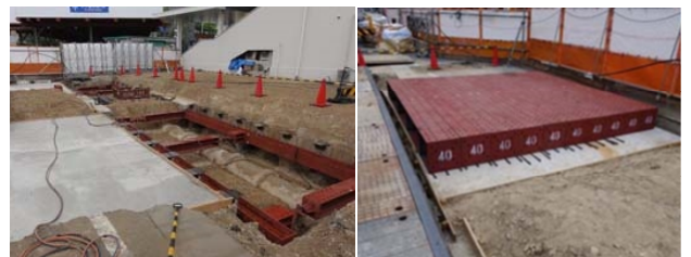
写真 6 クレーン下の埋設管防護状況
