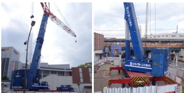
写真 4 大型クレーン設置状況
