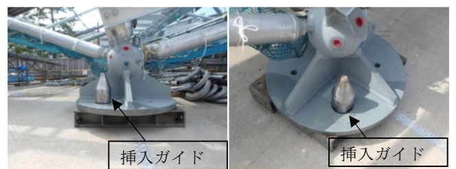
写真 10 地組時の支承部
