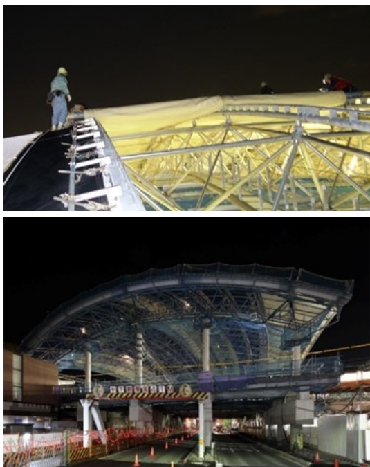
写真 11 1回目の展張作業状況
