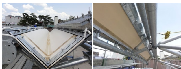
写真 12 軒樋の施工状況
