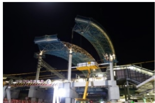
写真9 トラスブロックの架設状況
