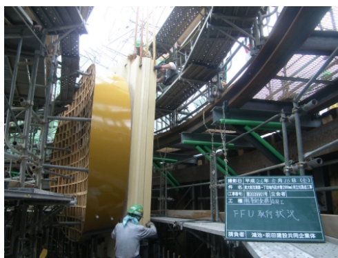
写真 7 坑口部円形型枠（左）と FFU（右）の取付け状況
