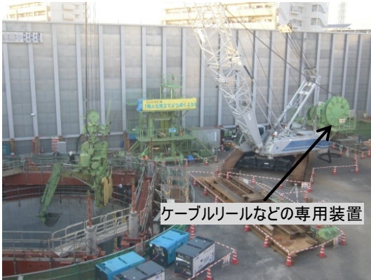
写真4 水中掘削支援機 (クレーンに専用装置を搭載)
