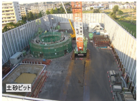
写真12 施工ヤード全景
