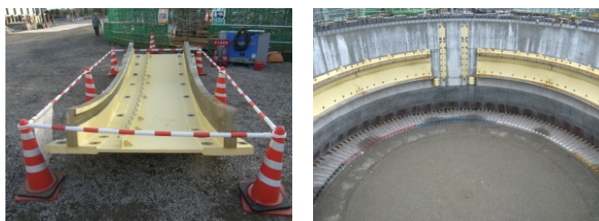
写真 6 走行レール（9 分割）と刃先部への設置状況
