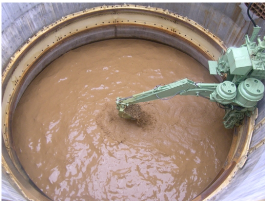
写真2 ケーソン刃先付近での水中掘削状況
