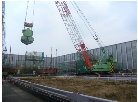
写真3 掘削揚土クレーン
