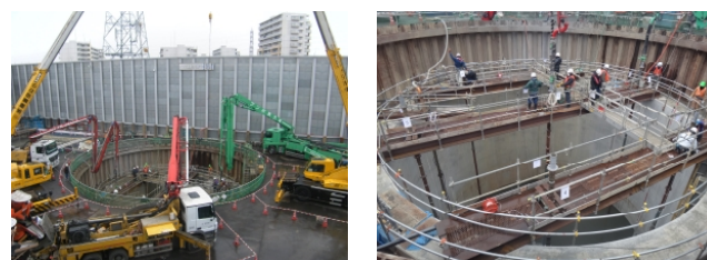
写真13 水中コンクリート打込み状況
