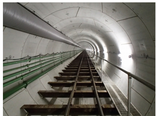
写真 8 シールド坑内状況
