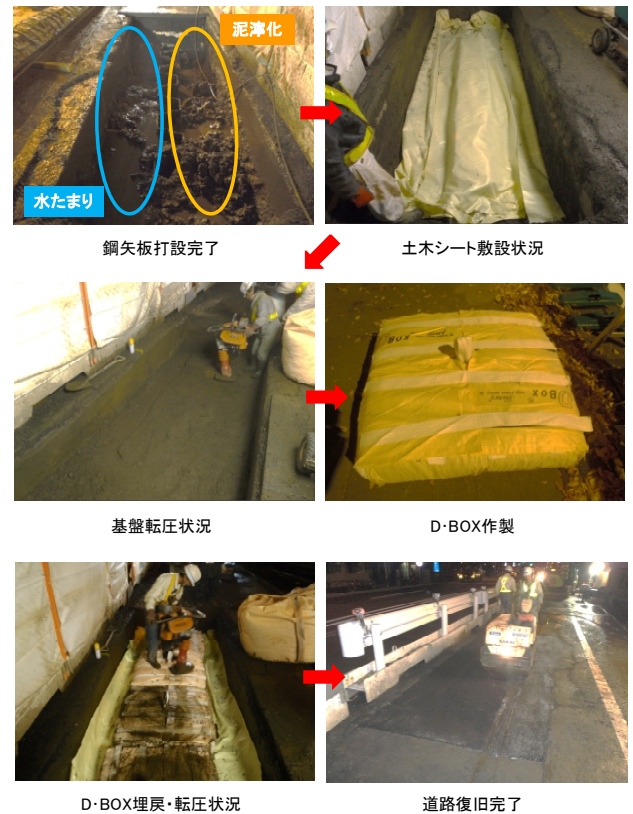
写真6 鋼矢板打設部舗装復旧フロー
