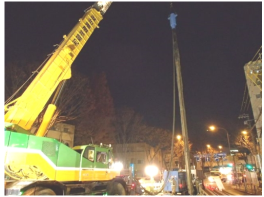
写真4 鋼矢板打設状況
