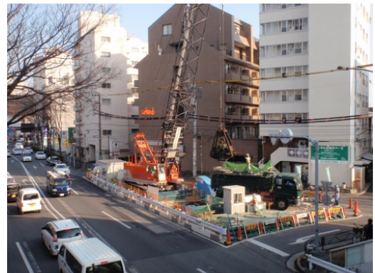
写真5 アーバンリング施工状況
