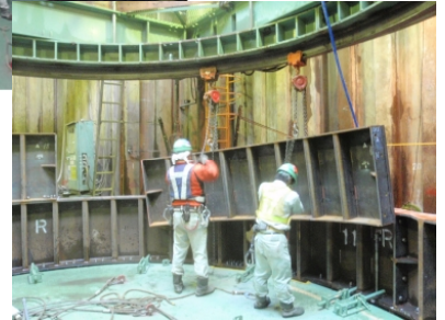
写真 7 アーバンリング施工状況
