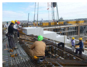
(PCa 段床設置状況)
