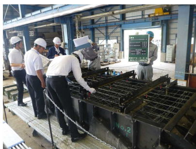
写真11 PCa工場にて鋼製型枠・配筋検査
