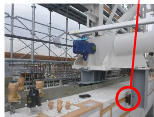
(屋根鉄骨先端)
