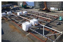
(地組み・溶接状況)
