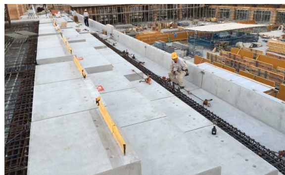
(PCa 段床設置完了状況)
