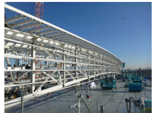
(屋根鉄骨の1ブロック)
