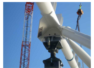
(トラス仮置き状況)
