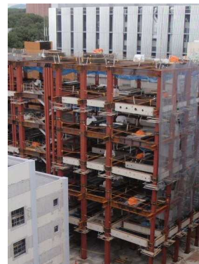
写真 10 架設された SC 梁
