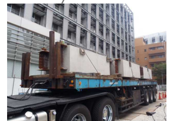
写真 9 搬入された SC 梁
