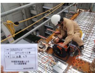
③圧入速度管理状況
