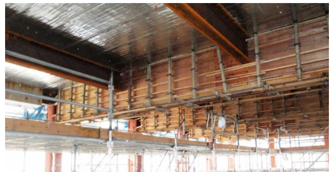
写真 11 ノンサポート工法
