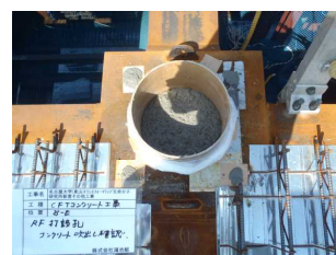
④コンクリート充填状況
