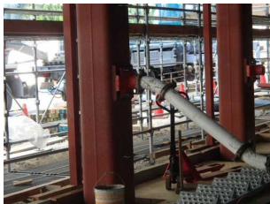
①小径 CFT 柱圧入口
