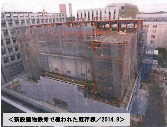
写真2 新設建物の鉄骨架設状況の推移 (名古屋大学提供)
