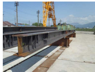
①製作された鉄骨梁
