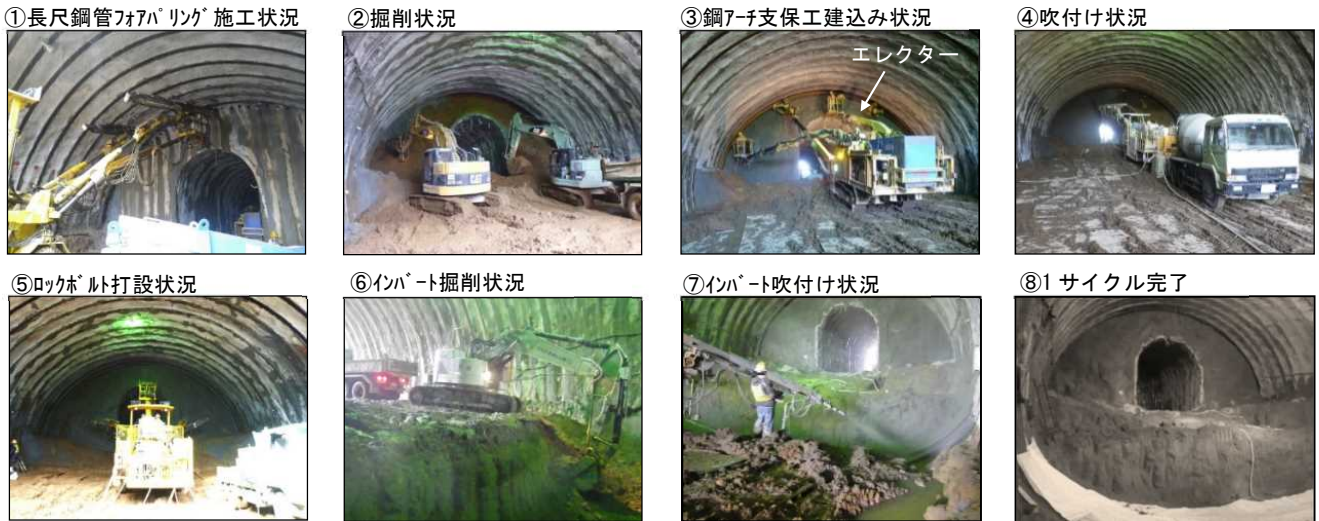
写真3 本坑施工状況
