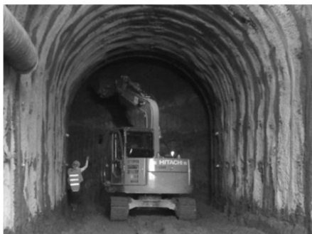
写真1 先進導坑の掘削状況
