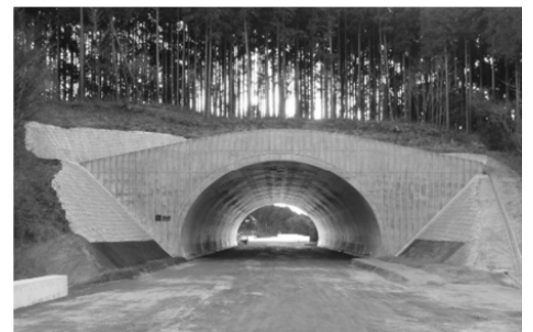
写真 5 本坑完成状況
