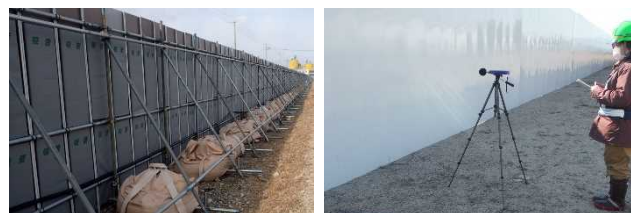
写真 14 吸音材付き仮囲いと騒音測定状況
