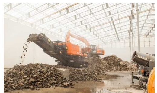
写真11 自走式クラッシャーによる破砕状況
