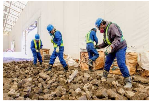
写真8 オーバー材(100mm~200mm)の手選別状況
