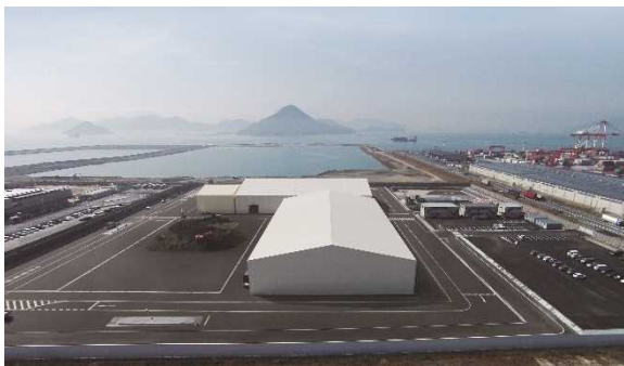
写真 1 中間処理施設全景
