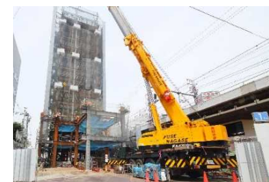
写真8 鉄骨建方状況
