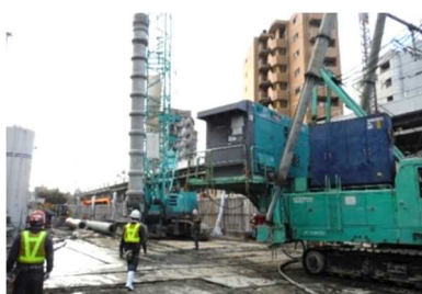
写真6 杭打設状況
