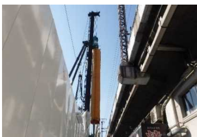
写真5 ソイルセメント壁施工状況
