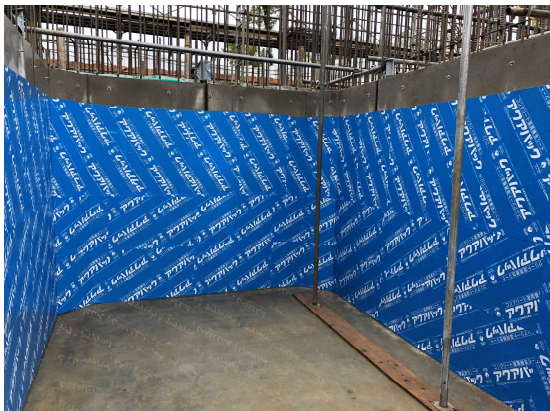
写真6 ポンプ場における適用状況
