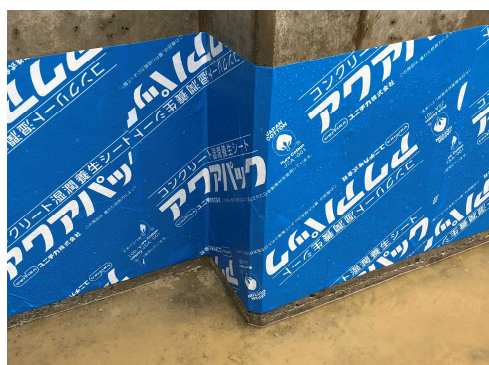
写真 3 屈曲部への貼付け状況
