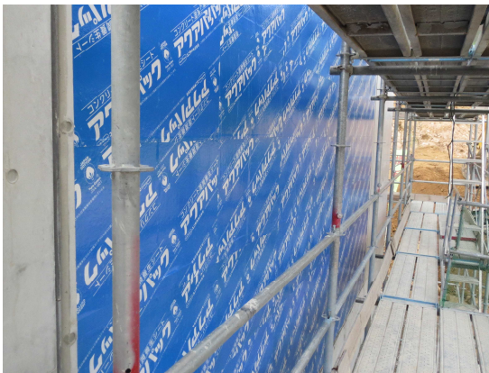
写真5 擁壁における適用状況
