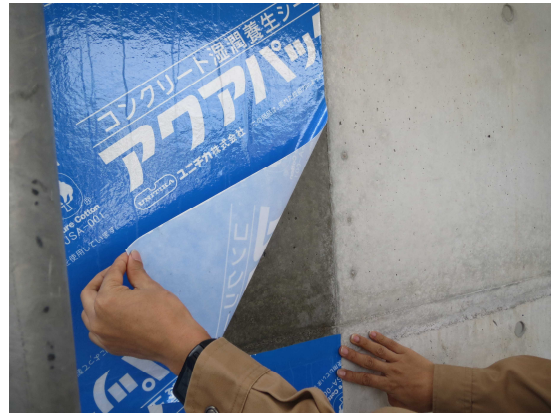
写真7 養生後のコンクリート面の湿潤状態
