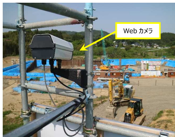
写真6 現場のWebカメラ設置状況
