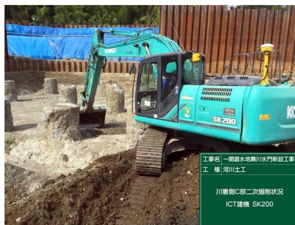
写真2 MC バックホウによる杭頭周囲の掘削状況
