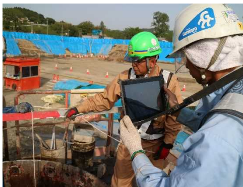
写真4 タブレット撮影状況
