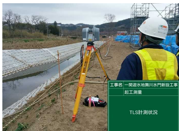
写真1 TLS 測量状況
