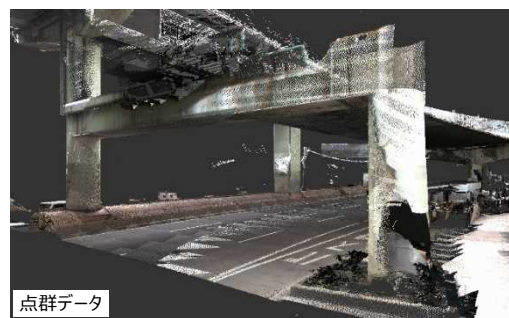
図 29 3 次元測量データの施工計画への活用
