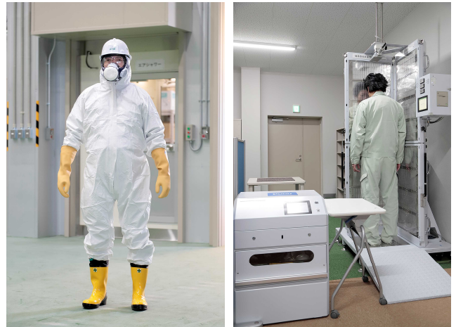
写真9 汚染管理区域内での保護具着用状況（左）と退域時の汚染検査実施状況（右）
