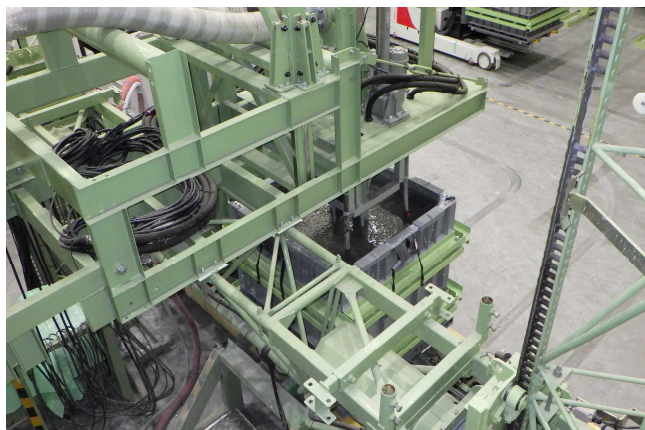
写真5 混練物の自動打設状況
