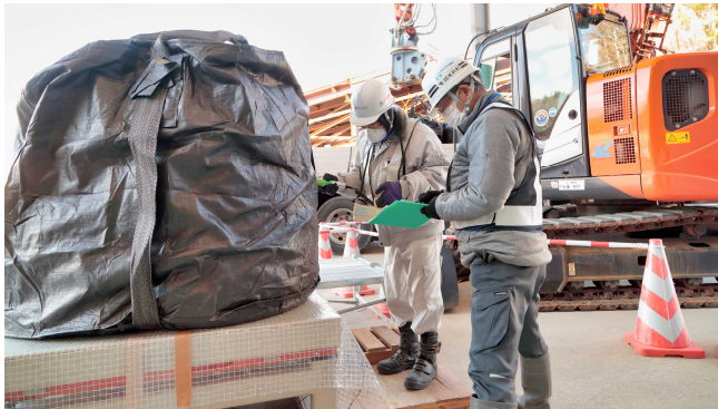
写真1 受入ヤードにおける表面線量率測定状況
