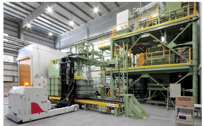
写真6 混練物が充填された型枠を運搬する自動搬送フォークリフト(AGV)
