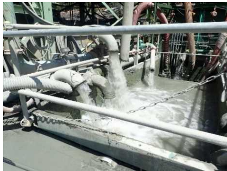
写真7 坑内からの排水状況 (5000L/min)
