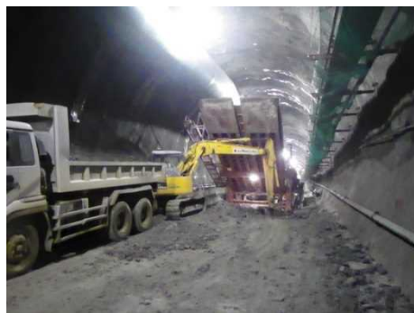
写真17 インバート掘削状況
