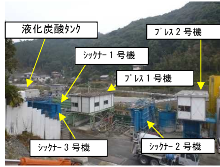
写真8 濁水処理設備 (360m³/h) 設置状況
