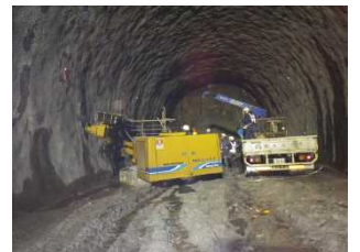
写真2 水抜きボーリング施工状況
