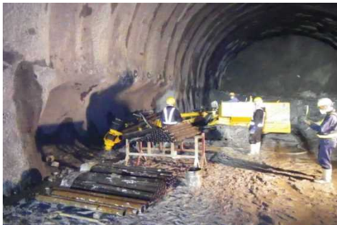
写真 3 No. 3 長尺ボーリング実施状況
