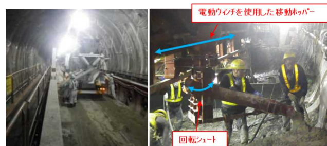
写真18 インバートコンクリート打設状況
