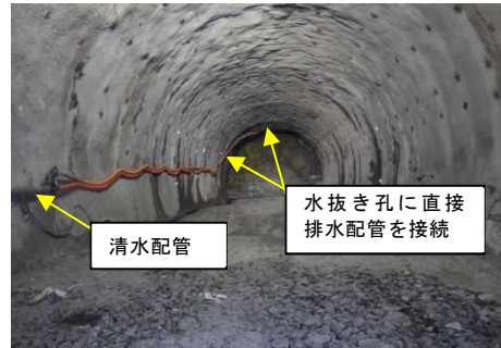
写真9 坑内清水分離状況
