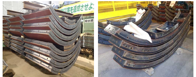
写真 10 セグメントシール全周貼り (一般部用と急曲線部)
