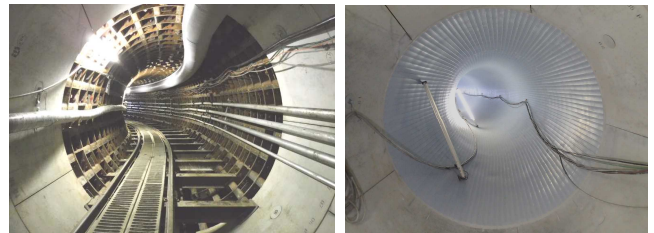
写真6 二次覆工施工前(左)とパルテム二次覆工施工後(右)
