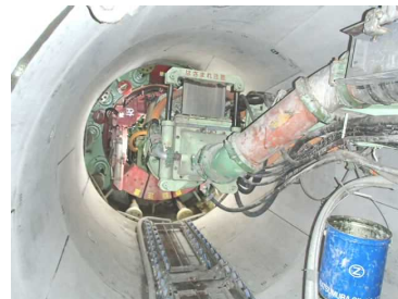
写真3 ノンタックホース接続状況 加泥材追加注入配管
