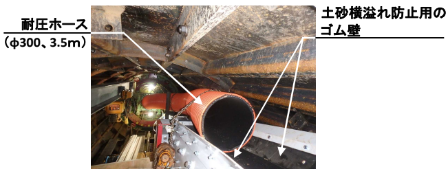
写真 11 耐圧ホースによる排土
