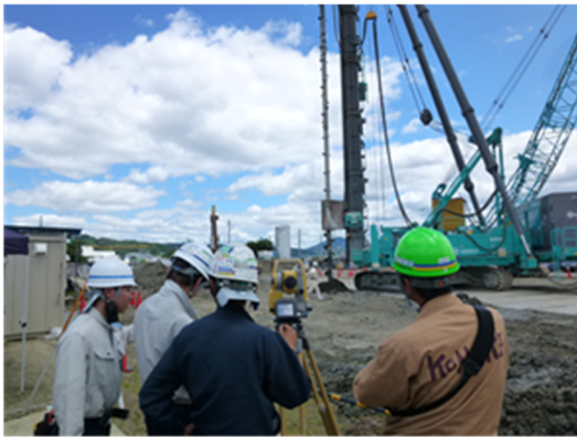
写真3 試験施工状況1
