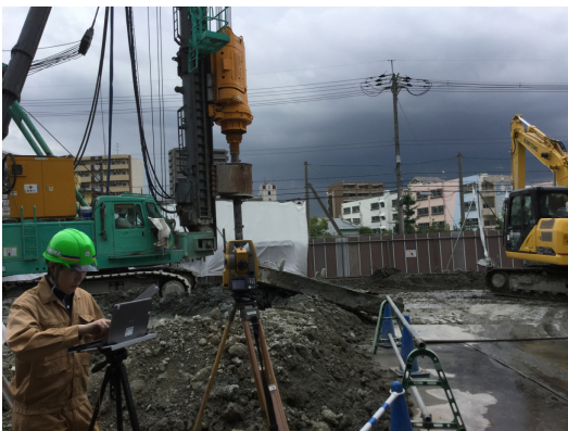
写真4 試験施工状況2
