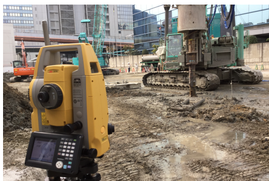
写真1 「杭打キング PLUS」の計測状況
