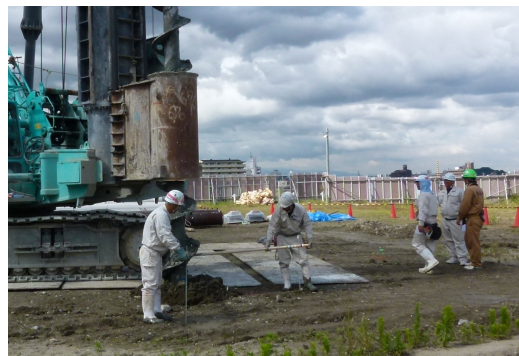
写真2 現状の施工管理状況
