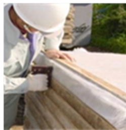
写真3 シート貼付け
