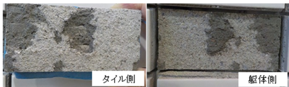
写真12 破壊状況の例 (AT4_3)
