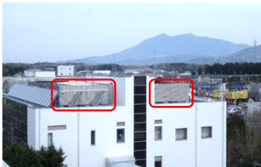
写真4 屋上目隠し壁の例
