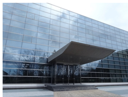
(a) エントランス庇の例
