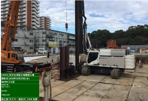
写真7 親杭打設状況 (写真7)
