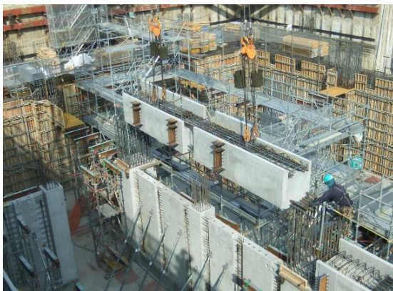
写真 9 梁 PCa 部材取り付け状況
