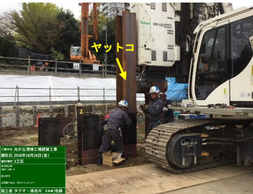
写真8 ヤットコ接続状況
