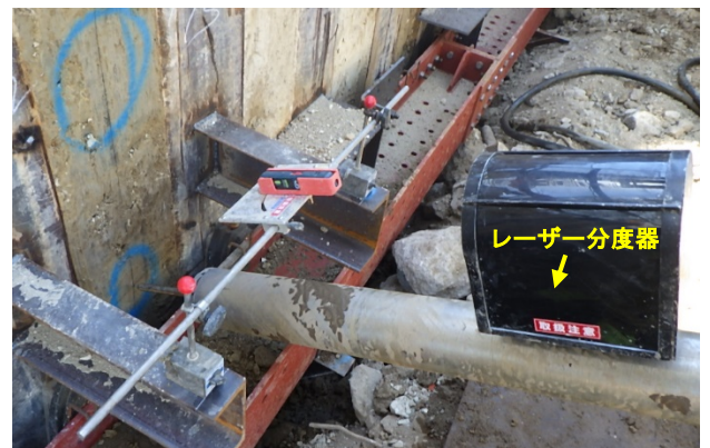
写真6 レーザー分度器を用いたアンカー傾角管理
