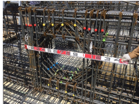
写真 15 大開孔基礎梁工法(補強筋)施工状況
