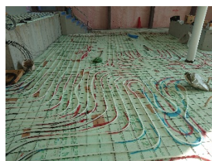
写真 6 床輻射施工状況
