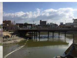
写真 10 構台架設
