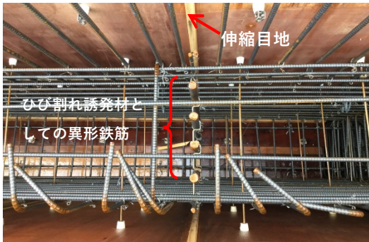
写真 13 CCB 工法施工写真
