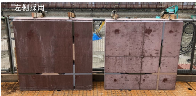
写真 11 カラーコンクリート外壁のモックアップ
