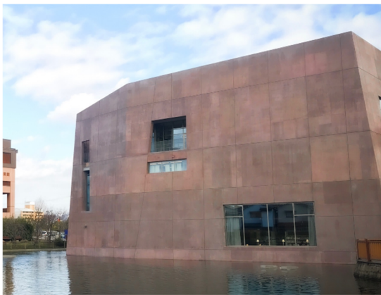
写真 14 6mピッチの外壁目地
