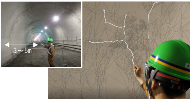
図 14 ひび割れ作図状況 (トンネル側壁部)
