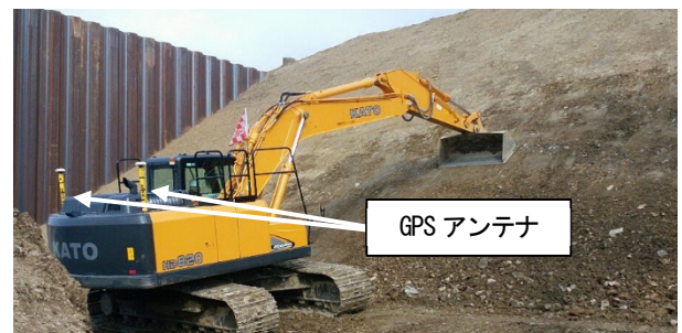
写真3 MCバックホウによる法面整形状況
