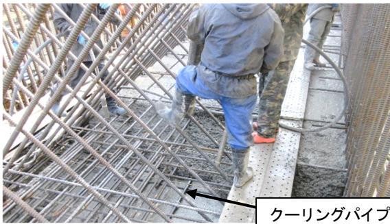
写真2 コンクリートの打込み状況
