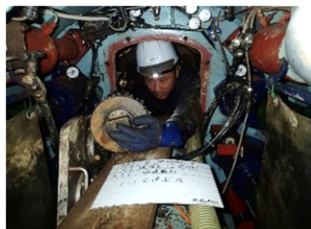
写真8 ビット交換状況
