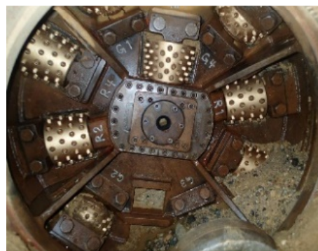
写真9 ビット交換後
