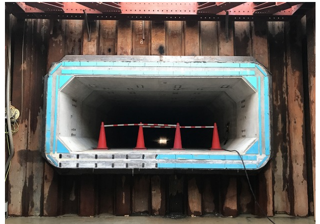
写真 13 ボックス推進完了 (到達立坑側)
