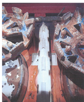
写真8 センター固定カッター
