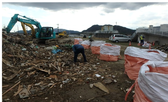
写真2 一次仮置場での手選別状況（東広島市）
