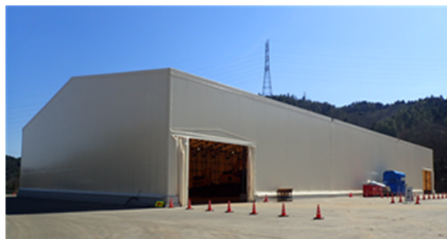
写真3 仮設テント全景（東広島市）
