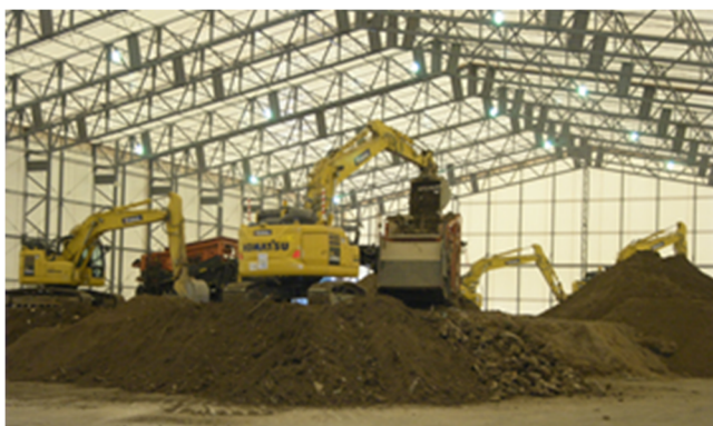
写真 4 仮設テント内作業状況（東広島市） （ガレキ混じり土砂の改質・分別）
