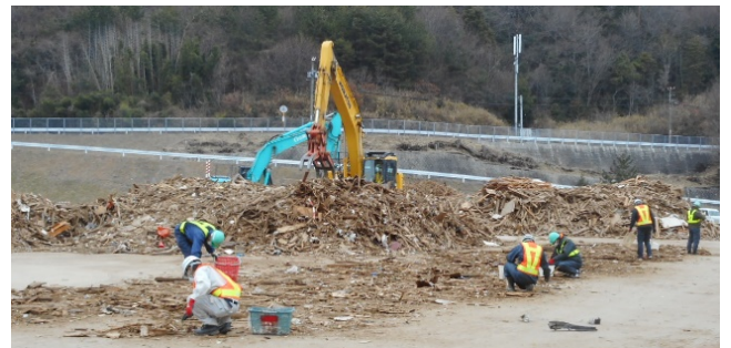
写真 6 廃家財等建物解体廃棄物分別状況（東広島市）
