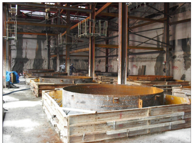
写真3 杭工事用スタンドパイプ立て込み状況
