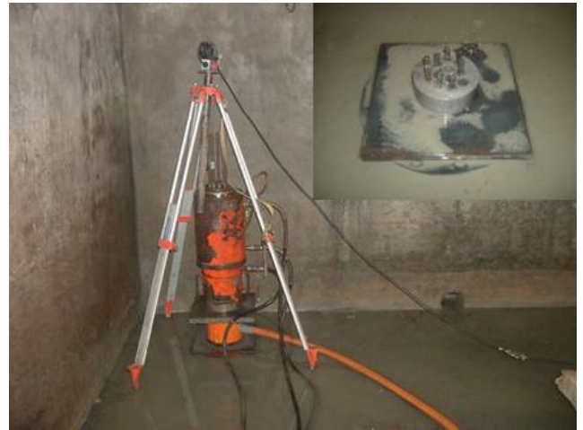
写真2 緊張力導入及び定着状況
