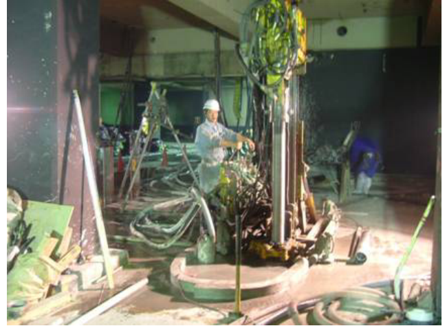
写真1 地盤アンカー施工状況
