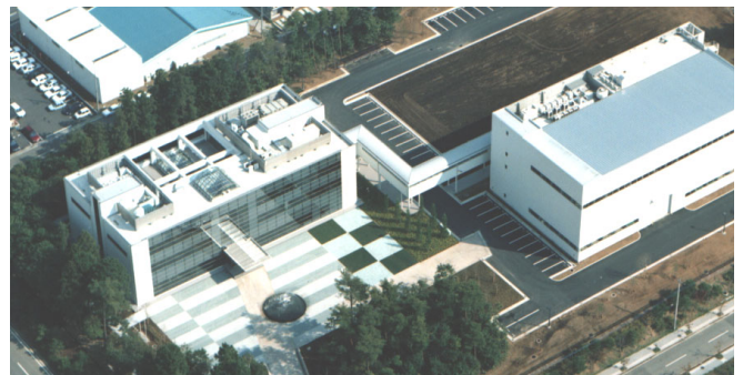
写真1 観測建物 左:管理研究棟(免震) 右:実験棟(非免震)
