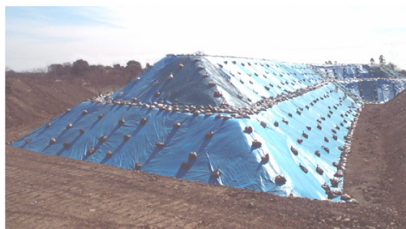
写真 3 不溶化処理土の仮置き状況
