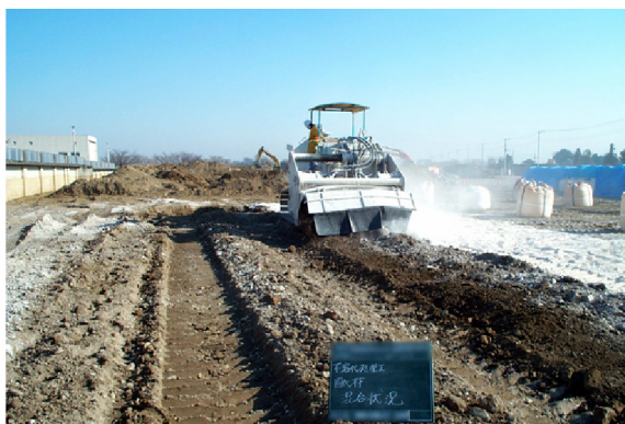
写真 2 不溶化処理施工状況
