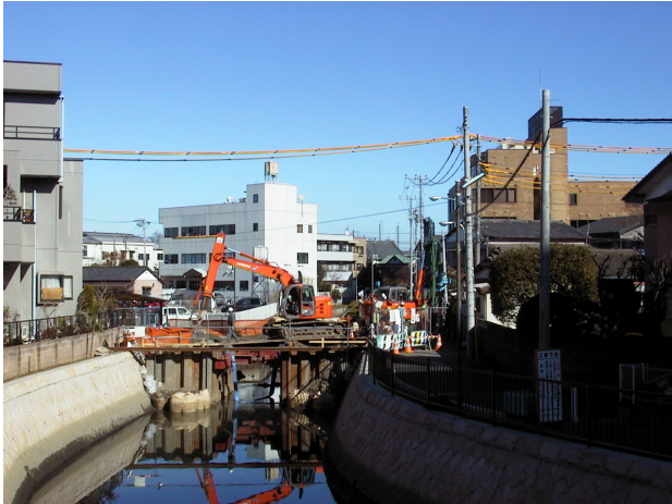
写真3 施工状況（全景）
