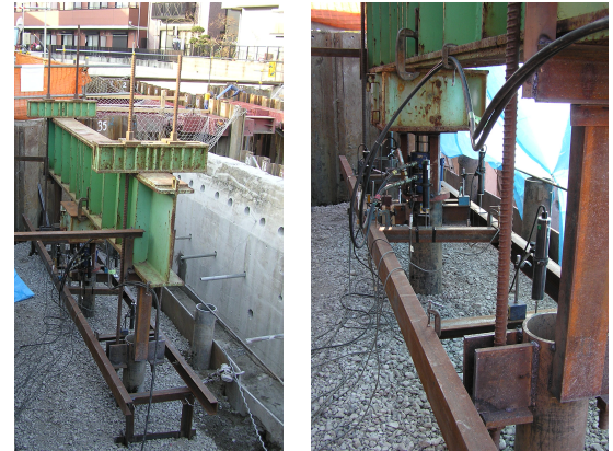
写真5 載荷試験装置
