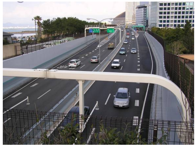
写真5 地盤改良域の地震後の状況 (路面に変状がなく液状化の痕跡もなし)
