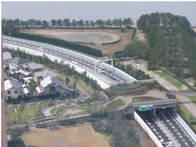
写真3 地盤改良域の地震後の状況 (高速道路に液状化の痕跡なし)
