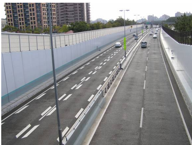
写真4 地盤改良域の地震後の状況 (路面に変状がなく液状化の痕跡もなし)
