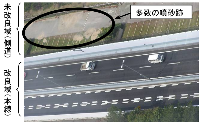
写真7 高速道路本線と側道の地震後の状況 (未改良の側道には多数の噴砂跡あり)
