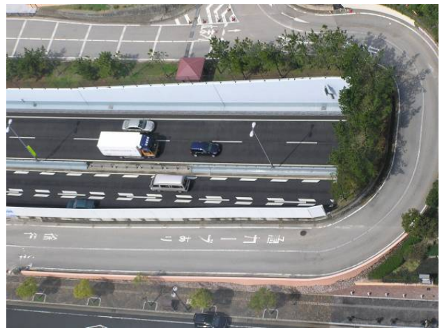
写真6 地盤改良域の地震後の状況 (高速道路に液状化の痕跡なし)
