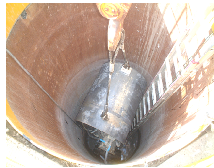
写真13 里庄 推進機分割回収状況
