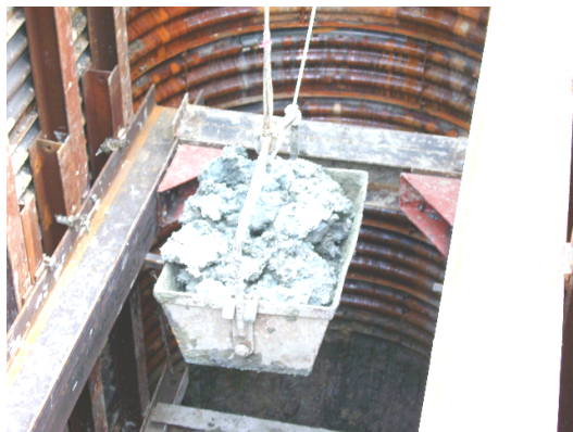
写真 17 宇部 粘土排出状況
