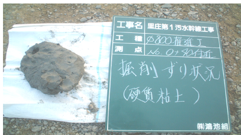
写真11 里庄 排出した硬質粘土
