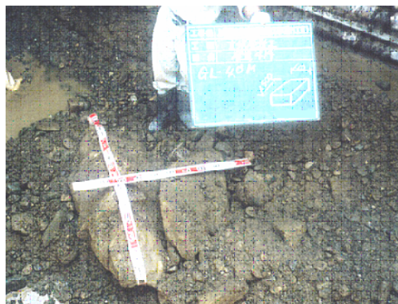
写真1 立坑掘削時に出現した巨礫の例
