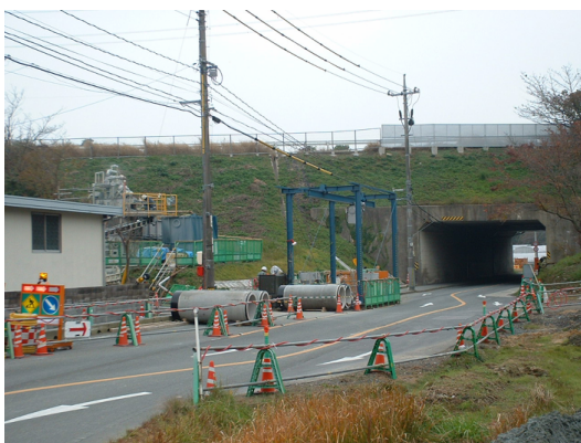
写真 16 宇部 工事場所全景
