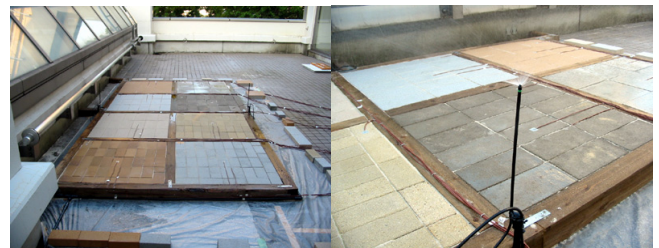
写真3 設置状況 (左), 散水状況 (右)
